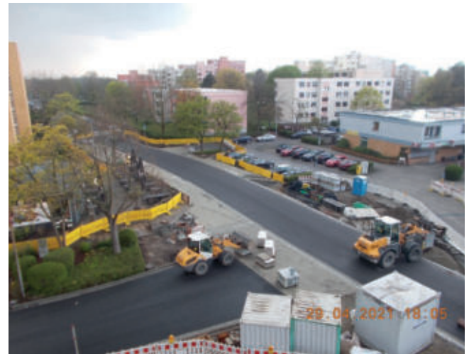
Bothfelder Straße nach Asphalteinbau
