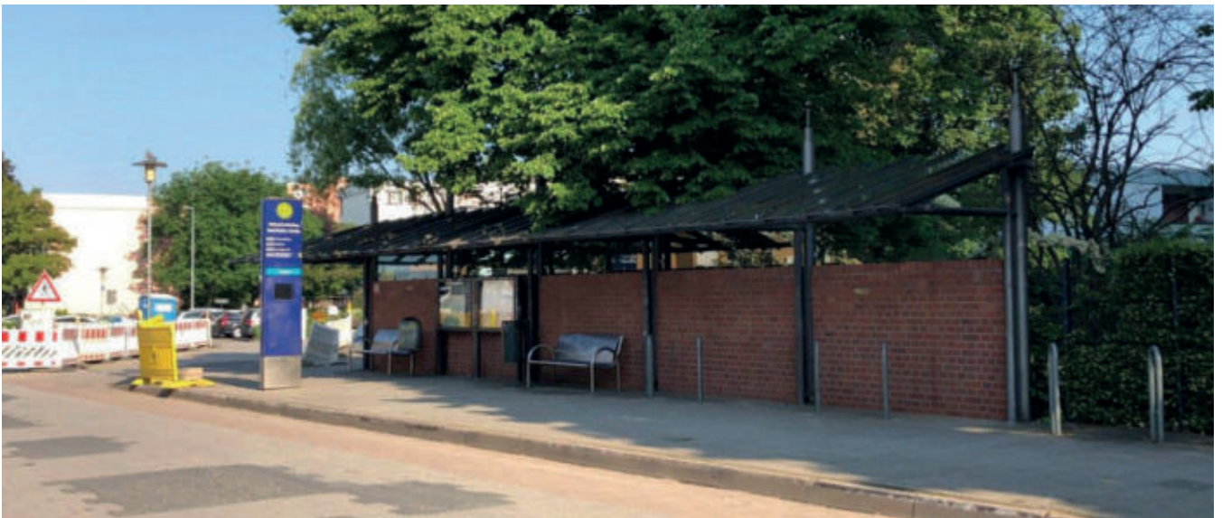
Alte Bushaltestelle nördlich Bothfelder Straße
