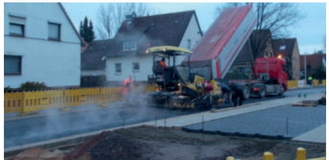
Baustelle Bothfelder Straße Ost
