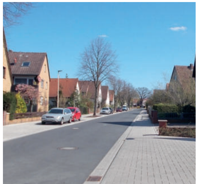
Nördlicher und südlicher Gehweg Bothfelder Straße Ost nach dem Umbau
