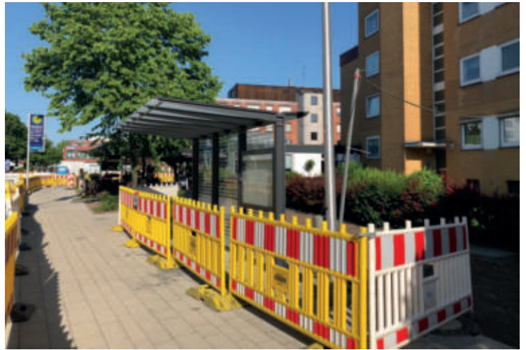
Neue Bushaltestelle südlich Bothfelder Straße
