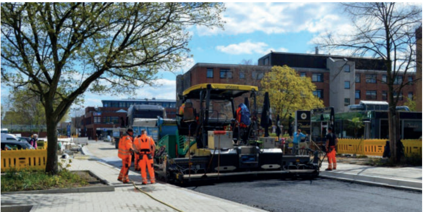
Baustellenfoto Bothfelder Straße - Asphalteinbau
