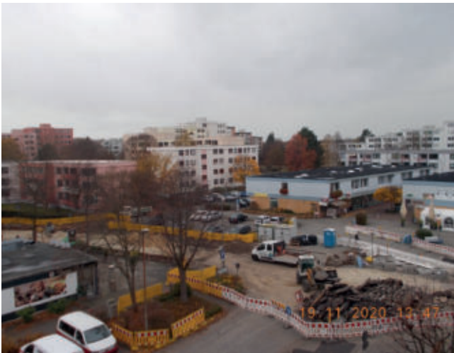
Bothfelder Straße zu Beginn der Sanierung des 2. Bauabschnitts
