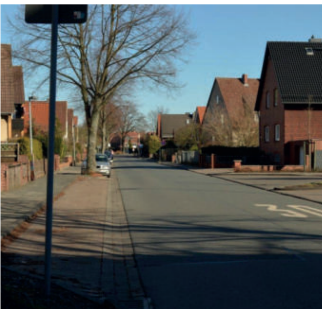
Nördlicher und südlicher Gehweg Bothfelder Straße Ost vor dem Umbau
